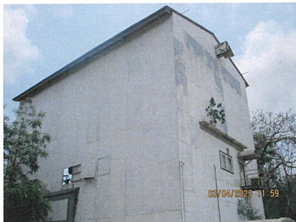
รูปที่ 8 ผนังปิดคลุมมิดชิดโรงโม่หิน
